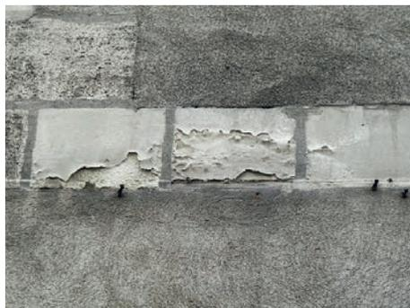
Après la pose d'un enduit au ciment, l'humidité dégrade les pierres du mur.
