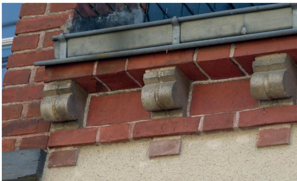
Cette façade d'une maison est restée dans son état du XIX<sup>e</sup> siècle. La toiture et les zingueries bien entretenues ont permis la conservation de la corniche en briques scellées au mortier de chaux, et de l'enduit d'origine composé de chaux et de sable.
