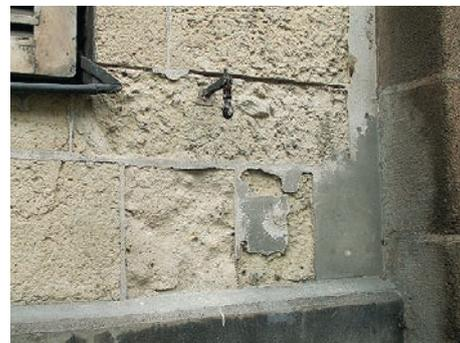
Dégradation d'un mur : l'humidité ressort au-dessus d'un soubassement cimenté.
