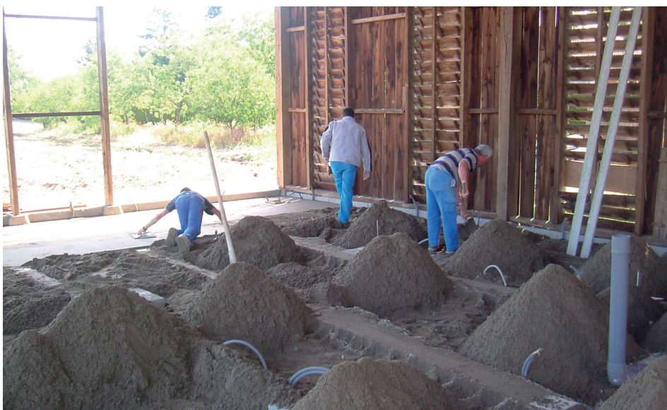
Chantier de réhabilitation d'un hangar à tabac
