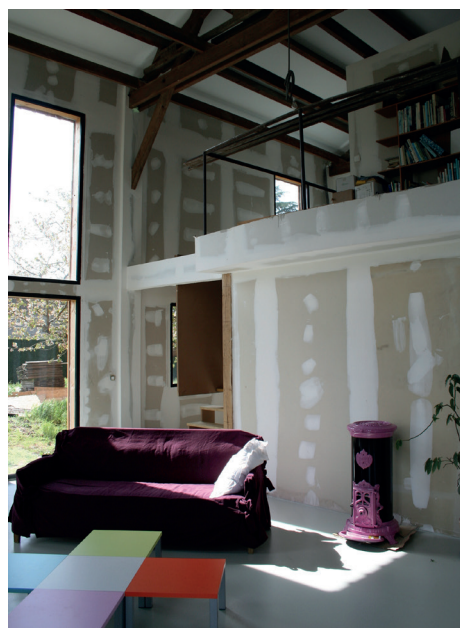
Chantier d'un hangar à tabac
