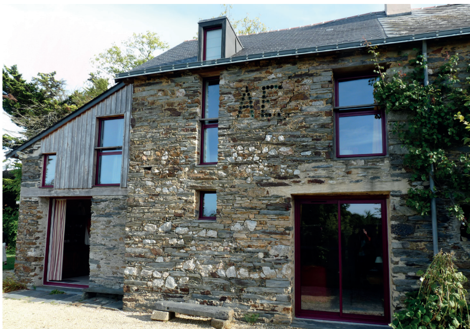
Le corps de ferme après travaux - Le Gâvre
