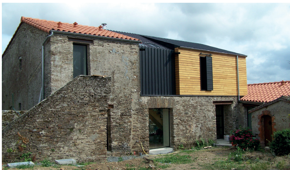
Transformation d'un maison du vignoble nantais.
