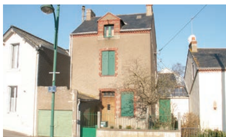
Maison de quai à Indre avec ses modénatures en brique.
