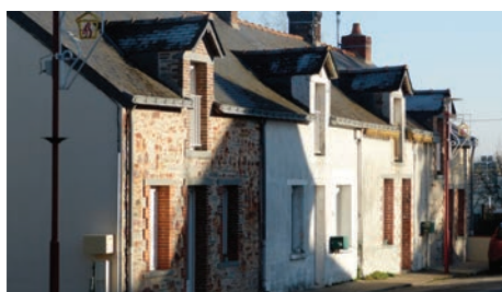
Petite maison de bourg près de Nozay avec ses encadrements en brique.
