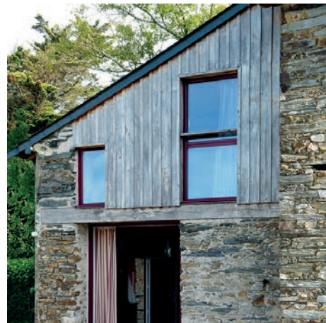
Ossature bois et bardage pour une surélévation. Le bois avec sa patine se marie avec la pierre.
