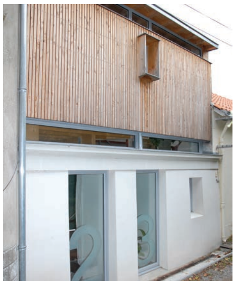
Surélévation d'une maison avec le bois comme matériau de façade.
