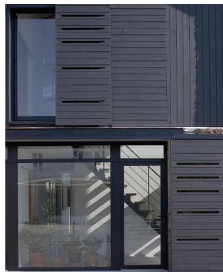
Bardage pose verticale, horizontale et volet coulissant.
