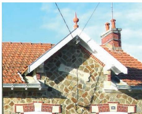
Toiture en tuiles mécaniques, épi, mitron sur ce chalet balnéaire.
