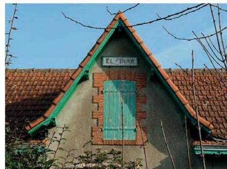
Pignon à toiture débordante, avec tuiles formant la rive de la toiture.
