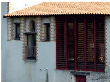
Couverture en tuile canal dite « tiges de botte » neuve. Les tons mélangés de la tuile s'adaptent au style architectural.
