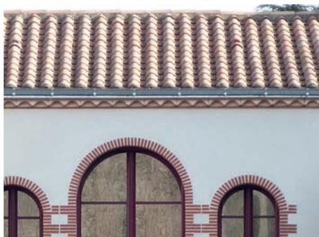
Couverture en tuile canal dit « tiges de botte » avec son faîtage scellé.
