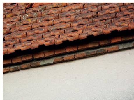
Débord de toiture sans gouttière au-dessus d'une corniche en brique.
