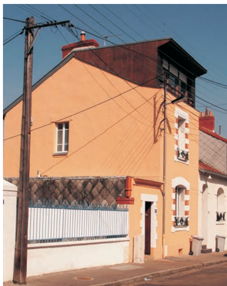
Surélévation en rupture sur une maison ancienne.
