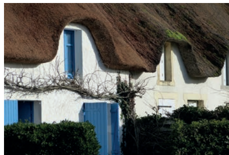
Détail de la couverture au-dessus des lucarnes.
