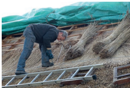
Le travail d'un chaumier sur la couverture d'une chaumière à Kerhinet
