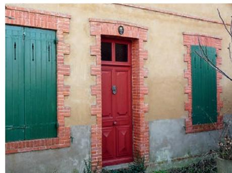
Enduit ancien au ton sable, avec encadrements de brique et menuiseries vertes et rouges. On regrette la réfection du soubassement qui, au lieu de ciment, aurait dû utiliser un enduit à la chaux et au sable, avec un grain plus gros et une teinte légèrement plus sombre.
