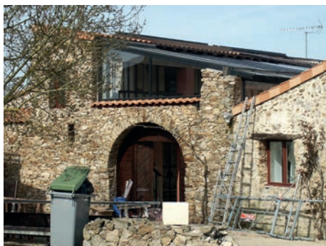
Intégration d'une véranda en aluminium.
