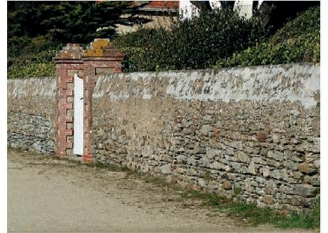
Les murs montrent des techniques de maçonnerie variée, et des pierres de teintes et de couleurs changeantes. Mais on doit songer à leur pérennité, en ne laissant pas à découvert des pierres et leurs joints dégarnis, notamment en front de mer où les intempéries peuvent être agressives. Un entretien et une réfection avec des enduits à la chaux sont nécessaires.
