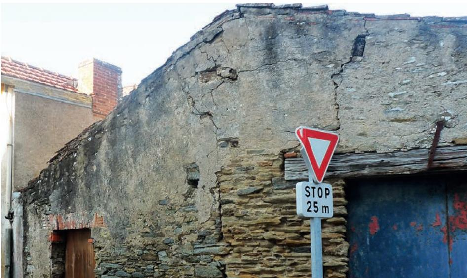
Cet ancien bâtiment présente des manques et des lézardes qui nécessiteront une restauration adaptée à ses maçonneries de moellons et de mortier de chaux.
