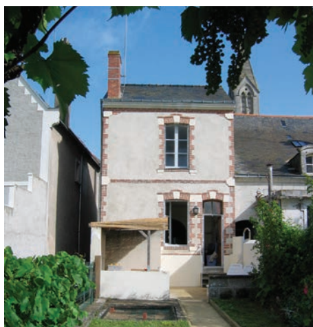
Maison de bourg restaurée avec le respect des modénatures (encadrements, chaînages...) François Mouzet architecte.
