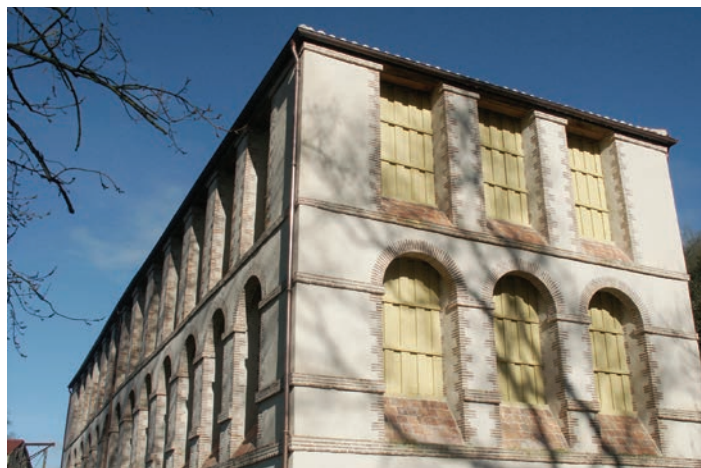
Séchoir à papiers du Liveau à Gorges, construit au XIX e et restauré par Forest Debarre, architectes en 2008.
