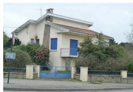
Escalier extérieur, conduit de cheminée structurant, poteau en pierre, balcon saillant, muret bas, portail et garde-corps au motif épuré.
