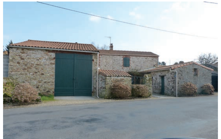
Une ferme, sud Loire. Elle est constituée de l'adjonction des différents usages accolés les uns aux autres.
