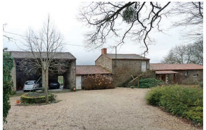
Une ferme, sud Loire, avec sa grange à piliers, sa tuile tige de botte, étendue par ajouts d'usages dans la continuité de la partie habitation.
