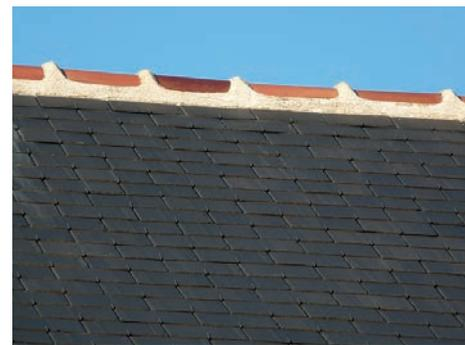
Faîtage réalisé en tuiles sans emboîtements, avec bourrelets de mortier de chaux.
