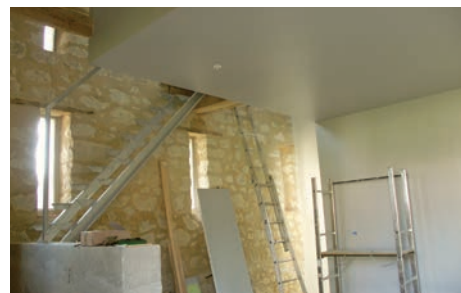
Chantier de restauration.
