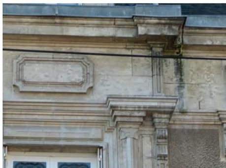
Appui de balcon mouluré soutenu par trois consoles sculptées appuyées sur le linteau de pierre.
