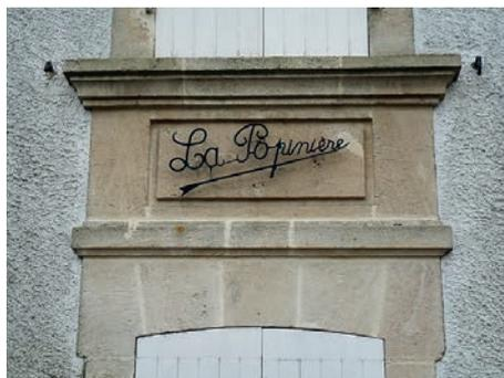
Entre l'appui mouluré de la baie de l'étage et le linteau à bandeau du rez-de-chaussée, allège en pierre de taille à panneau mouluré.
