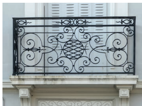
Garde-corps d'un balcon.
