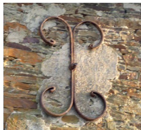
Fer d'ancrage, élément structurel de la maison.
