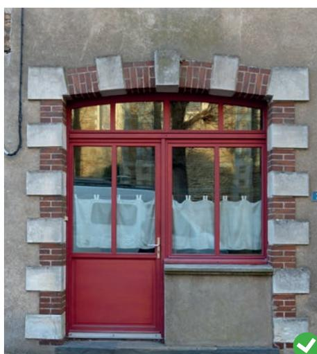
Ensemble en bois à l'écriture étudiée. Le soubassement de la porte reprend la hauteur de l'allège de la fenêtre. Les modénatures, de pierre et brique, sont conservées. L'allège maçonnée reprend la finition de la façade.
