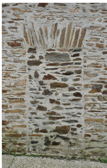
Boucher une ouverture. On observe le « fantôme » de l'ouverture. La pierre joue ici parfaitement son rôle dans le rebouchage de la baie.
