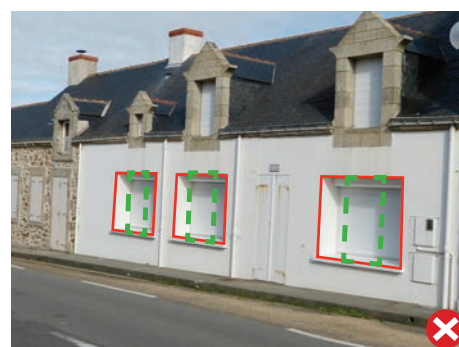
Les proportions des baies du rez-de-chaussée plus larges que hautes ainsi que les volets roulants amoindrissent l'harmonie de la façade.
