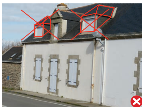
L'ajout de lucarnes, plus larges que hautes sur le pan de toiture déforme la volumétrie et alourdit la composition.
