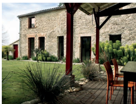
Cette restauration conserve les ouvertures existantes. Les vitrages vides de clair (un seul vitrage) s'harmonisent avec le bâtiment.
