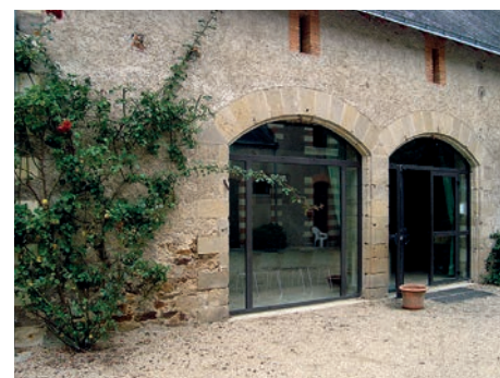
Création de baies dans d'anciennes portes charretières. Les baies s'intègrent parfaitement dans les ouvertures d'origine.
