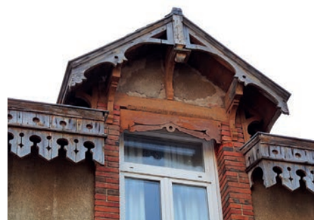
Bel auvent de toiture sur une lucarne avec dispositif en brique, bois peints, lambrequins et cache-store de style Art Nouveau en bois découpés.
