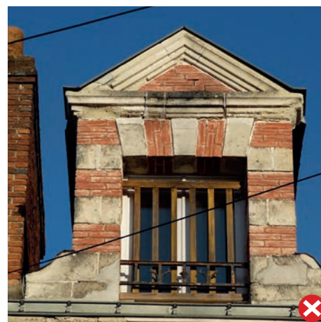
Le garde-corps en bois, qui vient doubler celui existant en fer, occulte la fenêtre.
