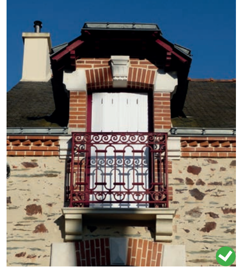
Cette lucarne ancienne a conservé son garde-corps ancien. Des volets repliables sont préférables à des volets roulants.
