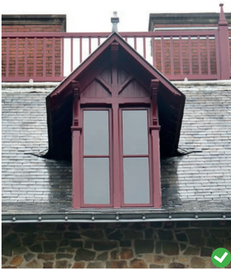
La couleur bordeaux crée un effet d'ensemble avec la fenêtre et les boiseries composant la lucarne.
