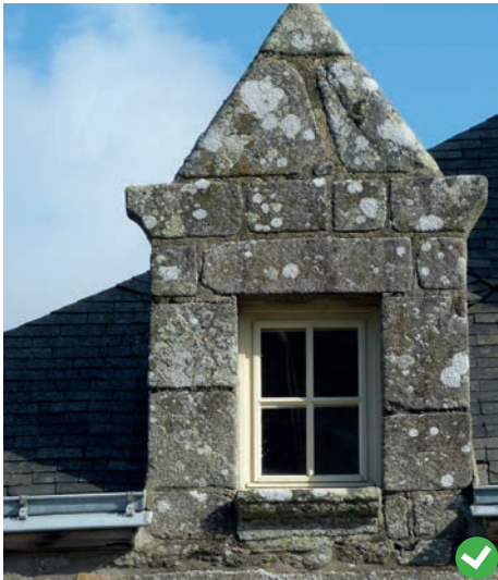
Une écriture simple, de fenêtre en bois avec ses petits bois.
