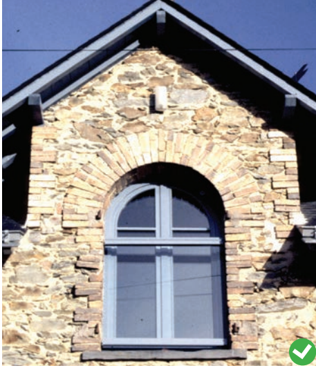
Une barre en bois fait office de garde-corps. L'écriture de la fenêtre de cette lucarne épouse parfaitement l'ouverture.
