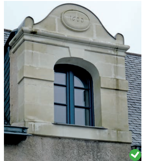
La fenêtre de la lucarne épouse parfaitement les contours de l'ouverture. La couleur bleu foncé par contraste met en valeur le percement.
