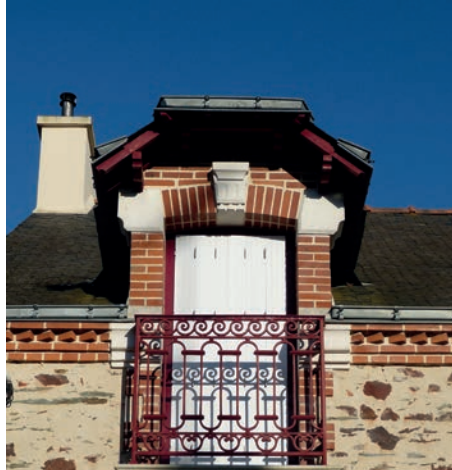
Lucarne à demi-croûpe avec son garde-corps et ses modénatures de pierre et brique.
