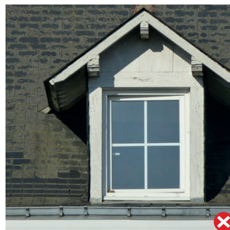
Le PVC de la fenêtre n'est pas compatible avec la lucarne en bois. De plus, l'écriture de faux petit bois amoindrit le caractère de ce patrimoine.
