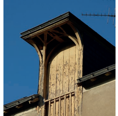
Lucarne en bois avec sa toiture rampante.
