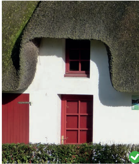
La couleur et le traitement des menuiseries en bois unifient les percements de cette chaumière.
